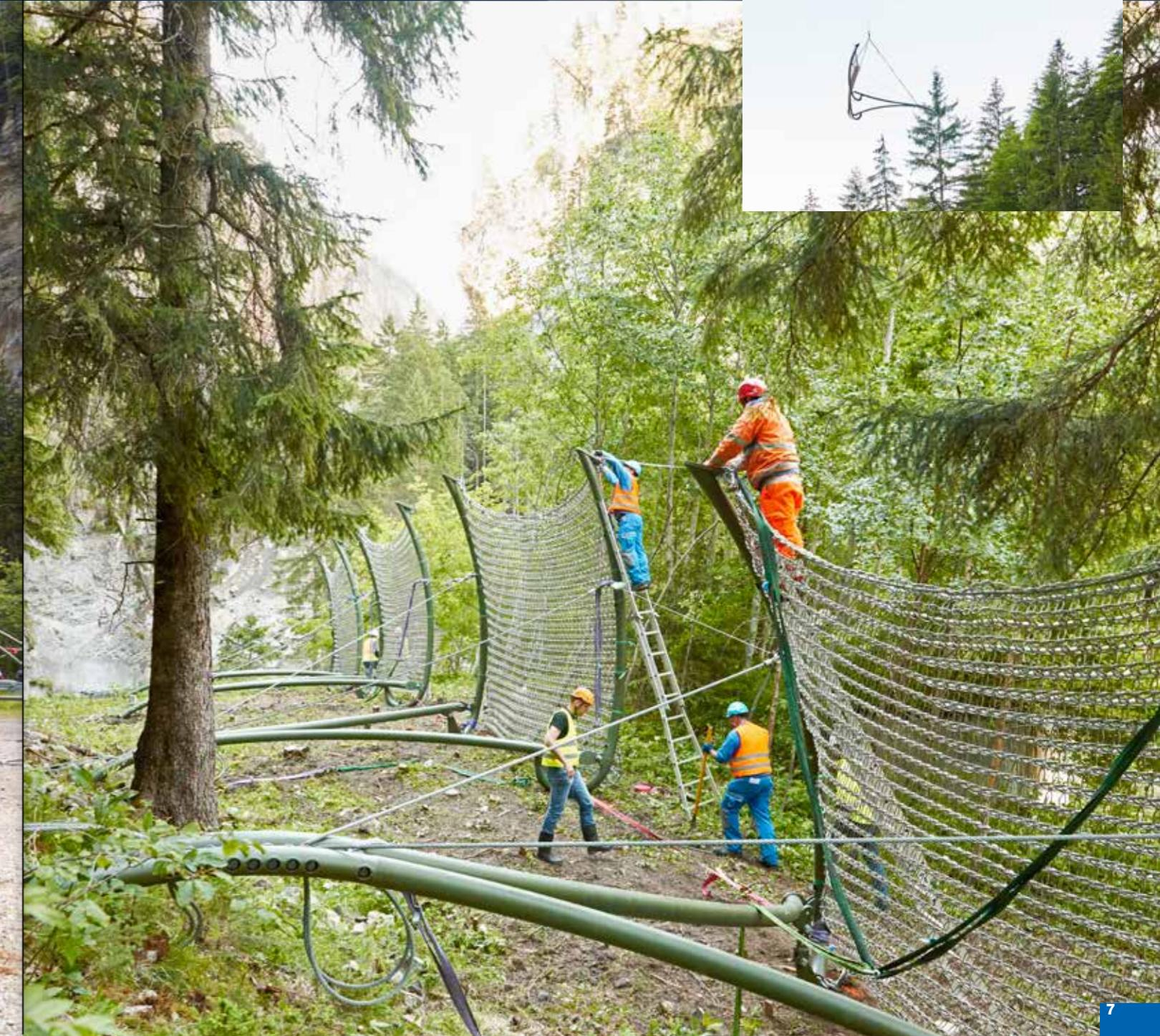
■ **Intelligente Statik**, bei der die Kraft durch Verformung vernichtet wird. Durch das optimierte, schlanke Design von **WebTree** wird das Landschaftsbild nicht unnötig gestört.
